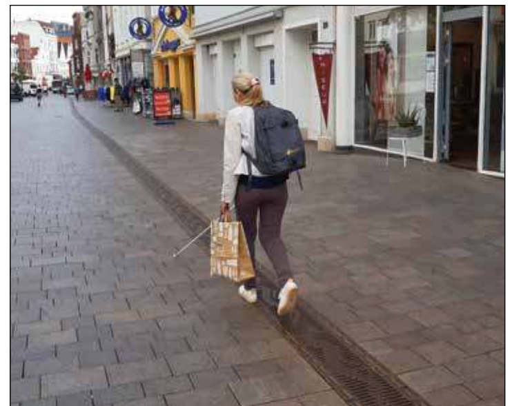
Die Blindenleitlinie führt durch die gesamte Fußgängerzone und ermöglicht Sehbehinderten, sich hier selbständig zu bewegen
